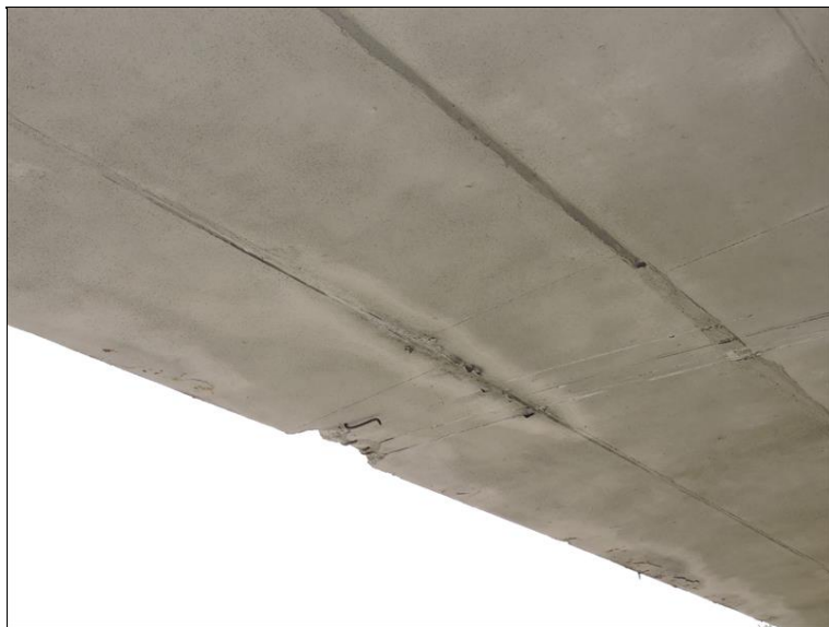
DSCN9578-resize.JPG Podhled NK - pole č. 1 - od nárazu kamionu
