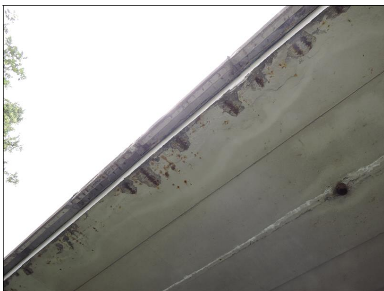
DSCN9573-resize.JPG Podhled NK pole 1 - opadaná krycí vrstva u P2
